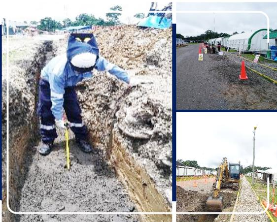
SUMINISTRO de ENERGÍA al Campamento desde la Planta; para lo cual requería la Instalación de una nueva subestación con todo su equipamiento; habilitando un punto de alimentación en una subestación existente, conexión y ruteo de cable de alimentación eléctrica hacia la nueva sub estación subestación. Instalación, facilidades y seguridad.
