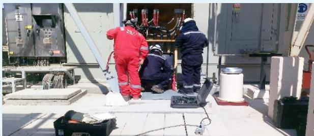
**EXTRACCIÓN y Análisis de Muestras de Aceite.** Equipos rotativos y transformadores de potencia.
